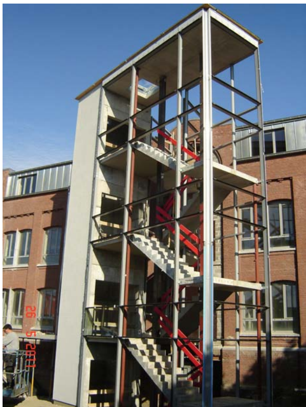
Réalisation de la tour pour l'ascenseur et l'escalier d'accès principal
