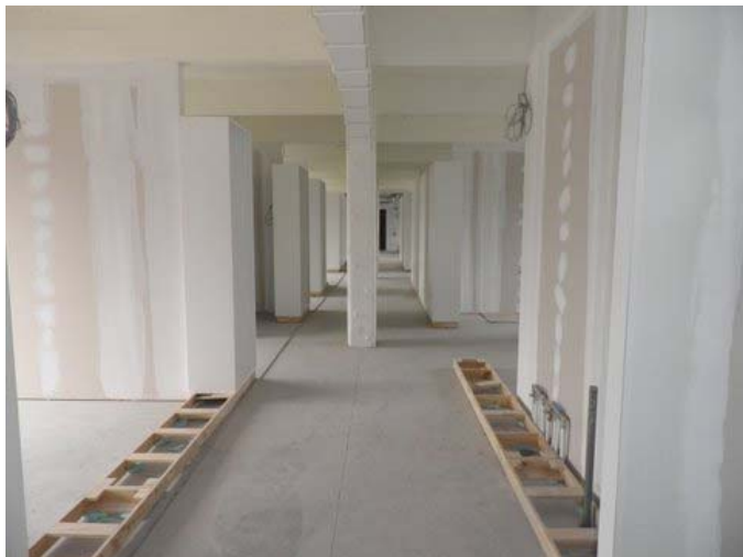
Préparation des armoires encastrées
