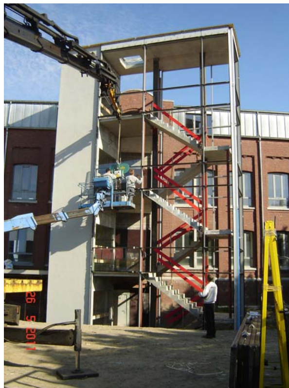
Réalisation de la tour pour l'ascenseur et l'escalier d'accès principal
