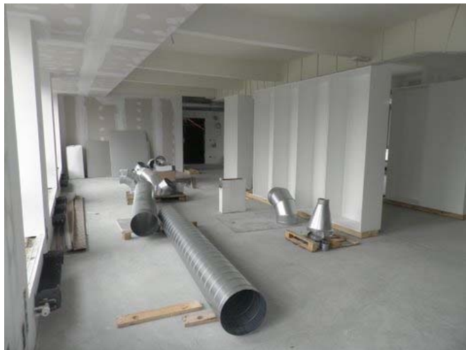
Installation du système de ventilation
