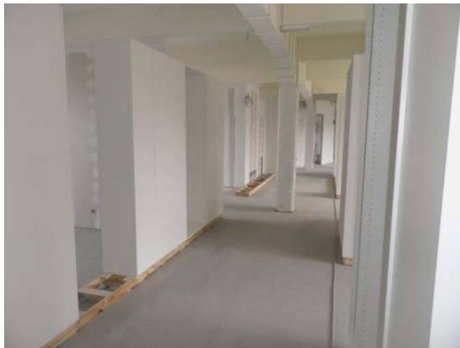
Pose des cloisons des bureaux du CPAS
