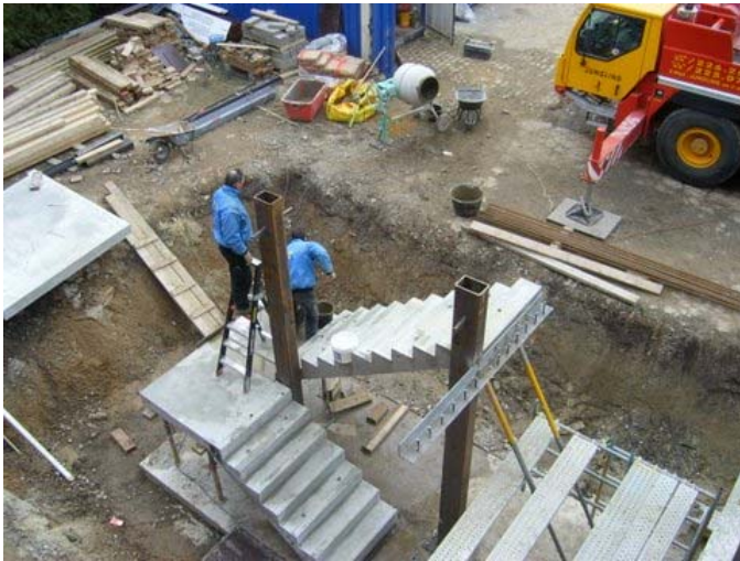
Réalisation de la tour pour l'ascenseur et l'escalier d'accès (suite)
