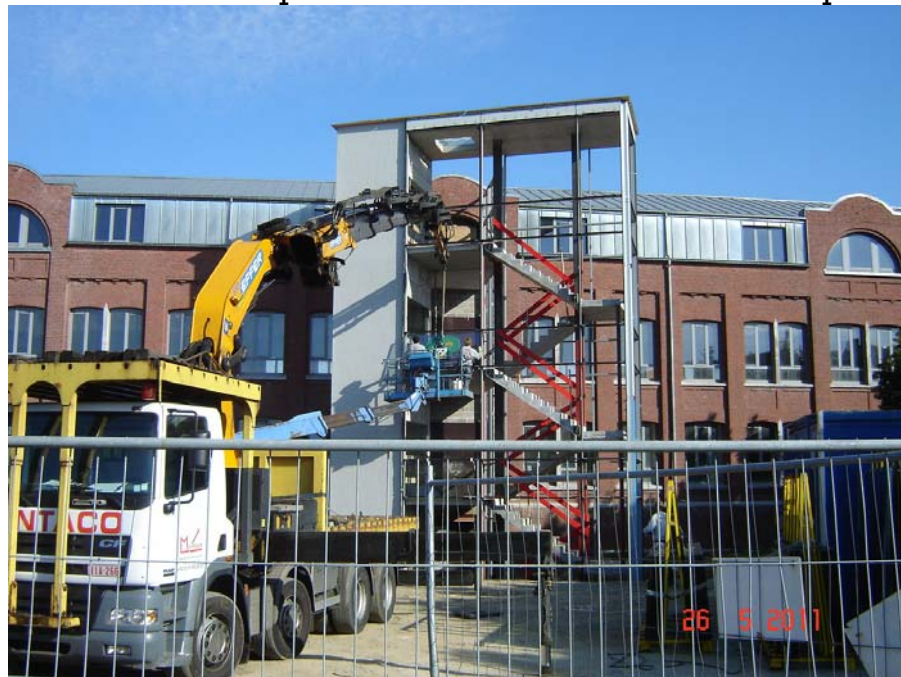
Réalisation de la tour pour l'ascenseur et l'escalier d'accès principal
