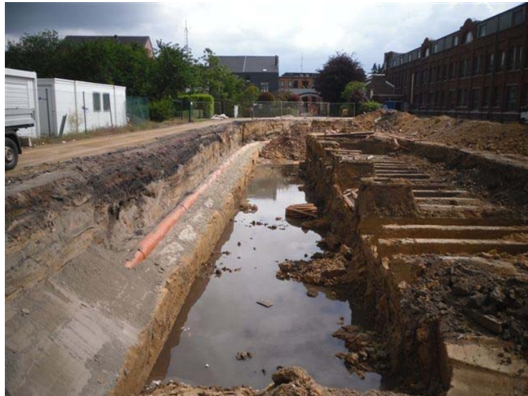
Création du nouveau bassin d'orage (650 m 3 )
