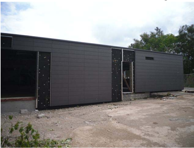
Nouveaux parements en tuiles de terre cuite
