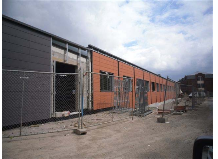
Nouveaux parements en tuiles de terre cuite
