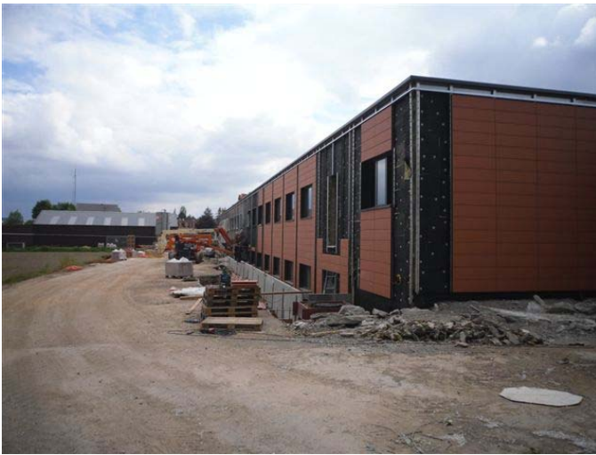
Nouveaux parements en tuiles de terre cuite
