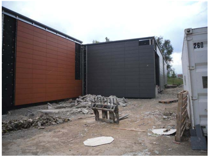
Nouveaux parements en tuiles de terre cuite
